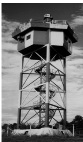
FIGURA 3.1 - Torre localizada no CTA, em São José dos Campos, onde foram instalados os equipamentos para registro de campos elétricos gerados pelos relâmpagos e a câmera rápida para as filmagens.
