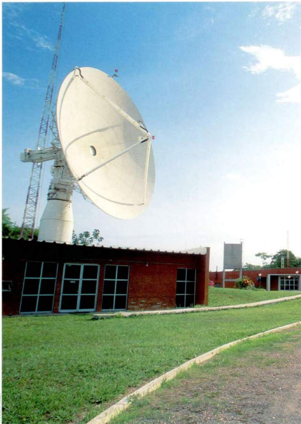
Antena de recepção de dados do SCD-1 em Cuiabá. Data reception antenna for the SCD-1 satellite in Cuiabá, Mato Grosso.
