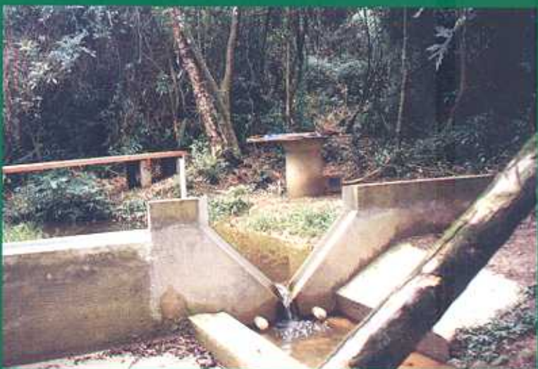
Fig. 8 Fotografia da plataforma e do vertedouro do riacho A no PEFI (Foto M.C. Forti).
