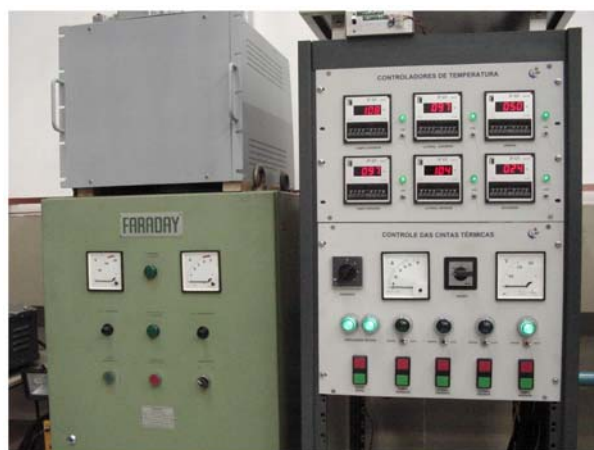
Figura 7. Sistema de aquecimento da câmara de vácuo do ETE com controle de temperatura.
